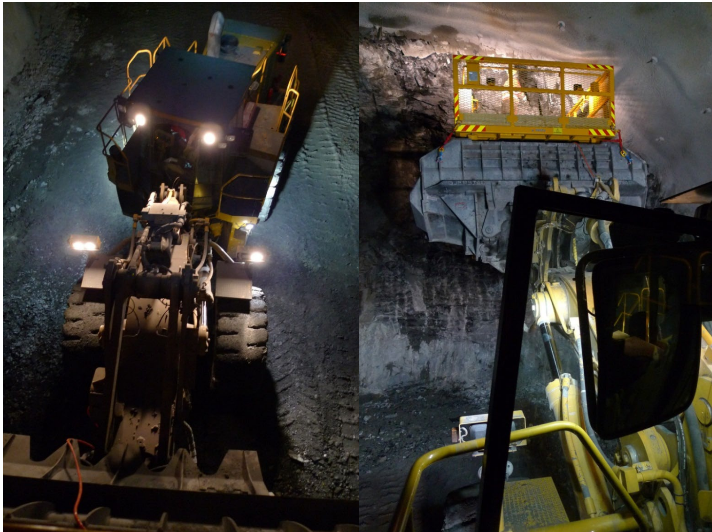
Registrering av bergarter, innlekkasje og andre forhold
