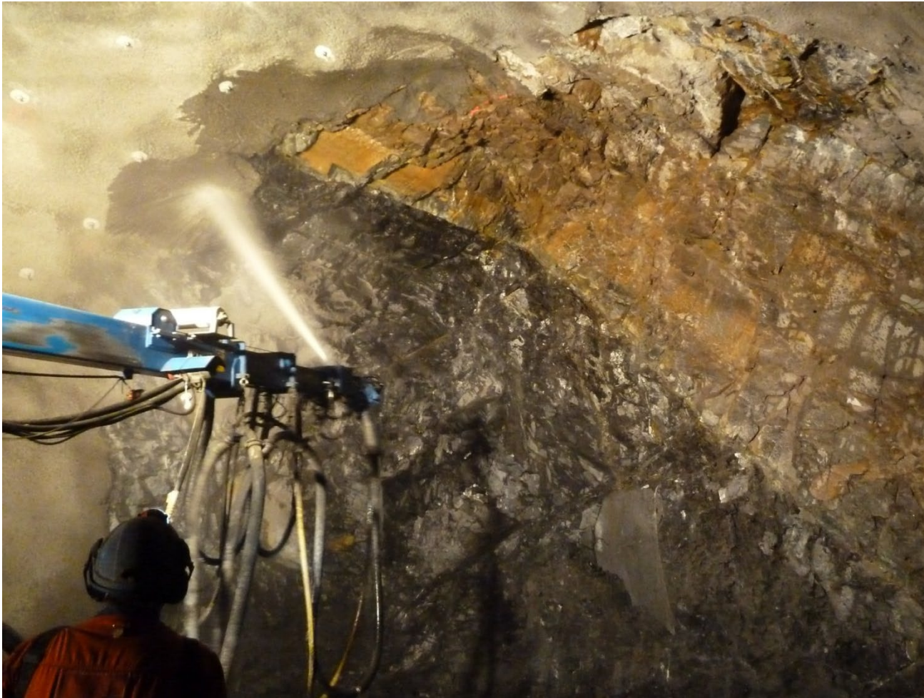
Sprøytebetong og bolteplater
