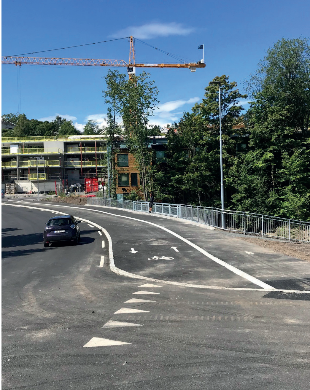
Sykkelvei med fortau i Nesveien
